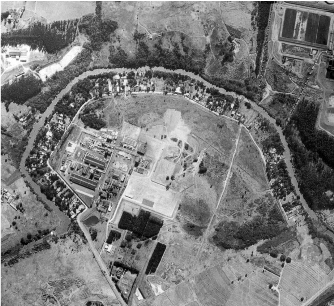
Figura 3- Visão aérea do Bairro Recanto dos Pássaros (antigo Poço Fundo) com edificações do antigo CISP e chácaras do entorno margeadas pelo Rio Atibaia.
