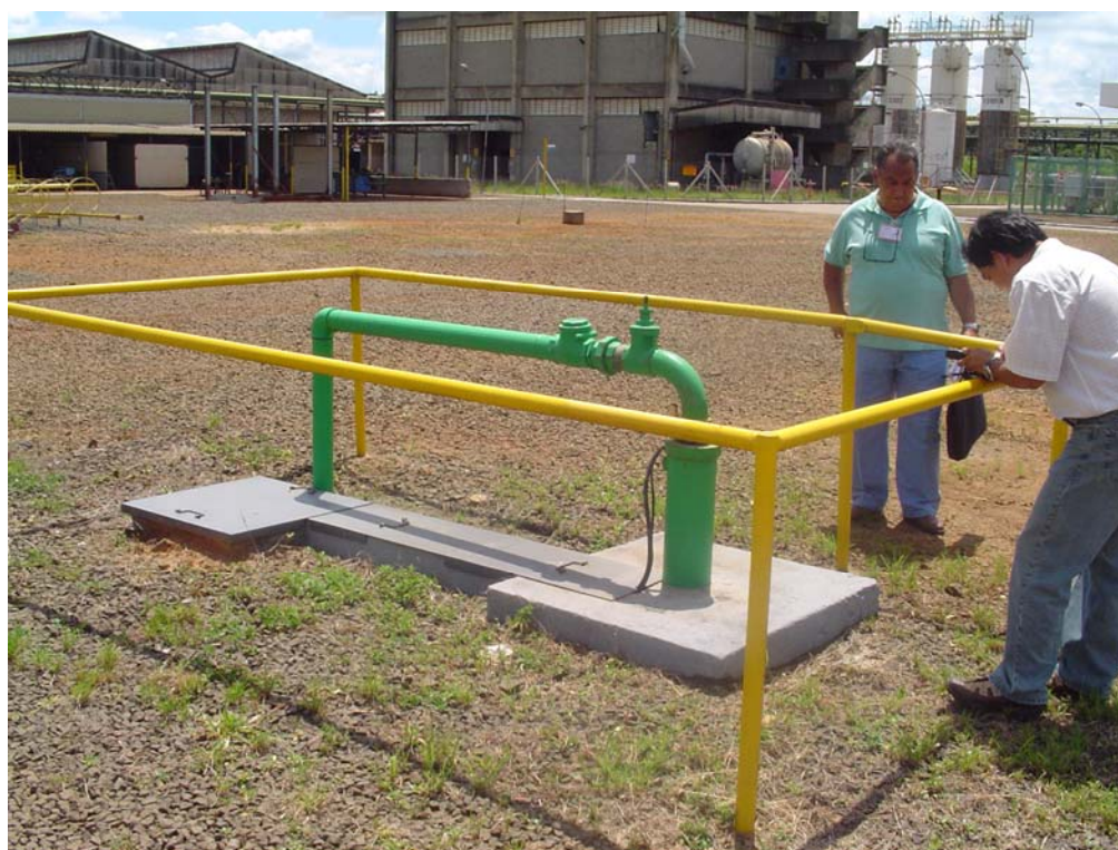
Foto 4: Registro fotográfico do Poço 4
